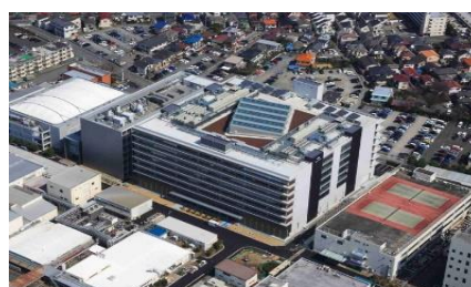
研究開発新棟に設置した太陽光発電設備(日本)
