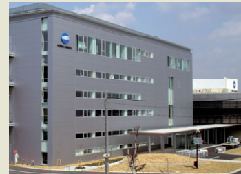
大阪狭山新棟
