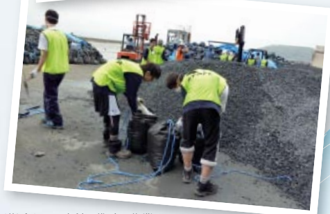
港近くでの砂利の袋詰め作業
